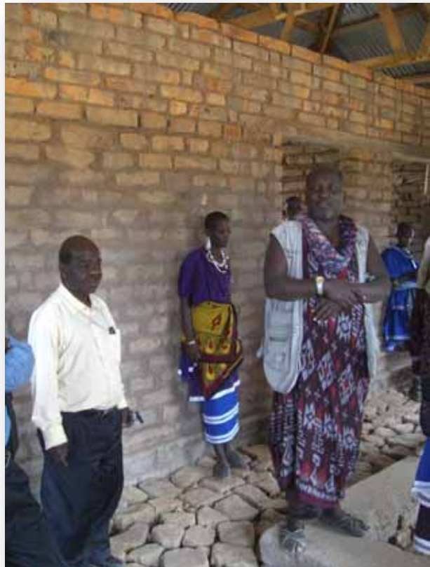
Pfarrer Mhitike (links) zeigt den Gästen die Baustelle des künftigen Pfarrhauses.
